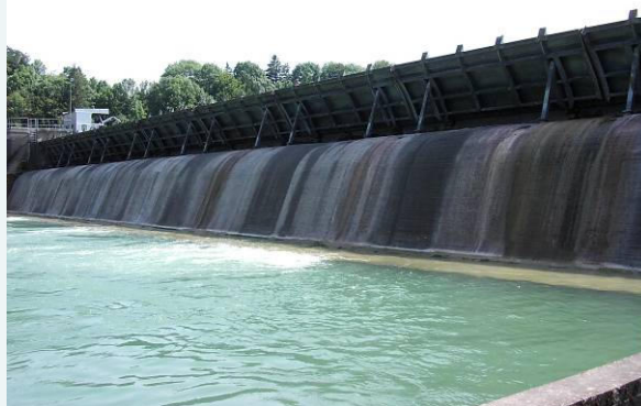
Kraftwerk an der Lech-Staustufe 9.
