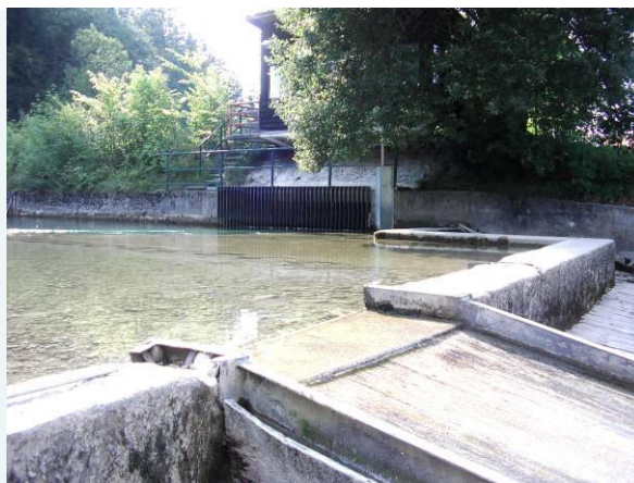
Ausleitungsbauwerk für das Kraftwerk Ammermühle. Ab hier führt die Ammer nur eine geringe Restwassermenge.
