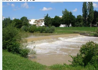
fkm 129,44 Wehr an der Au
