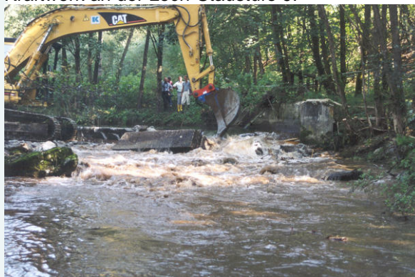
Positivbeispiel: Der Landesfischereiverband entfernt ein Wehr mit Wasserkraftwerk an der Mitternacher Ohe
